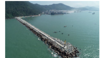
チャンメイ港防波堤 (日建工学(株)提供)
