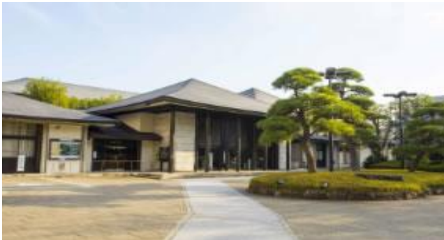
国立能楽堂（東京・千駄ヶ谷） 昭和58年（1983）開場
