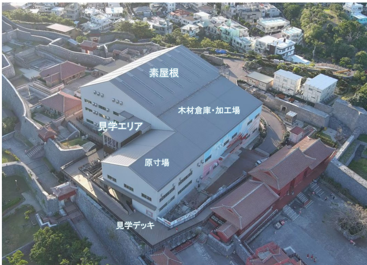
○現場の状況(R5.11.1撮影)
