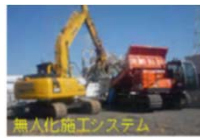
無人化施工システム
