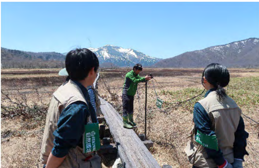
環境省との連携によるシカ防御柵設置
