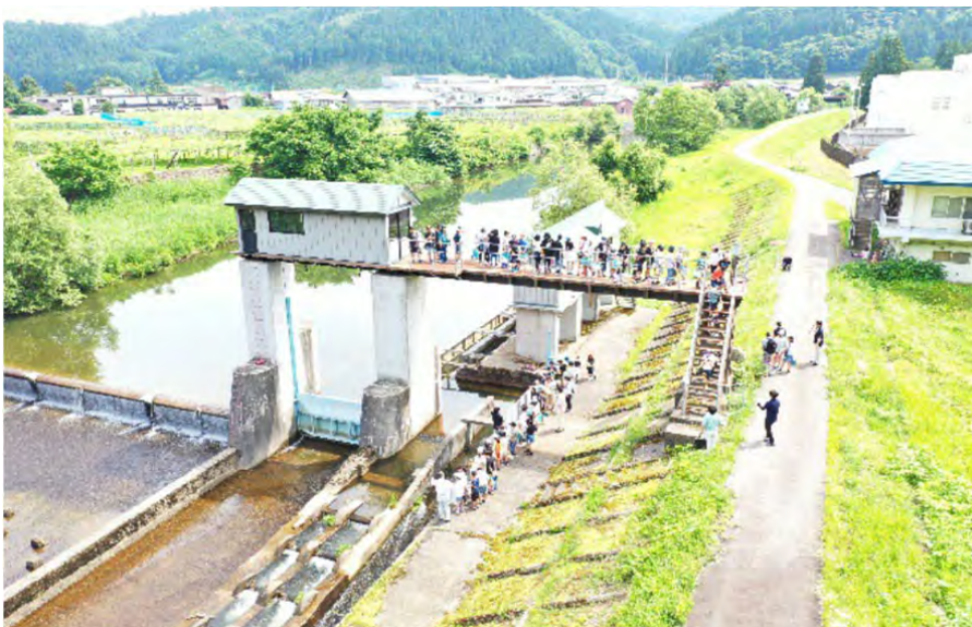
新一の堰頭首工見学
