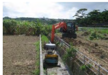
水路の土砂上げ作業
