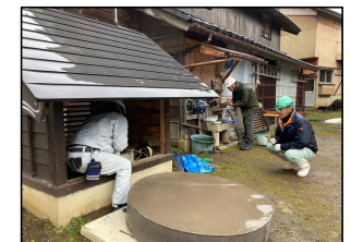
関係団体の既存井戸調査
