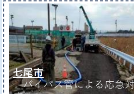
七尾市 バイパス管による応急対応
