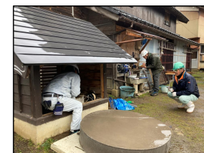
関係団体の既存井戸調査
