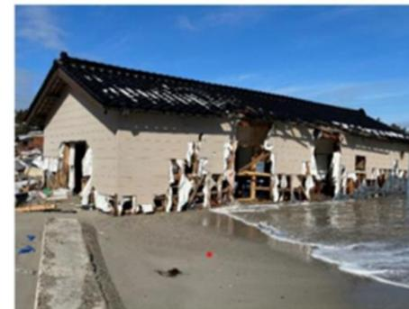
津波の引き波による住宅2階部分の流出状況（能登町）
