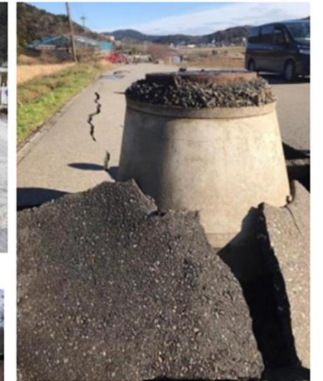
下水道マンホールの浮き上がり（輪島市）
