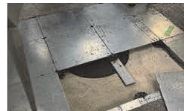
写真9 雨水の活用事例
