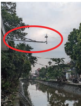
水路の流量を遠隔監視し用水管理を効率化
