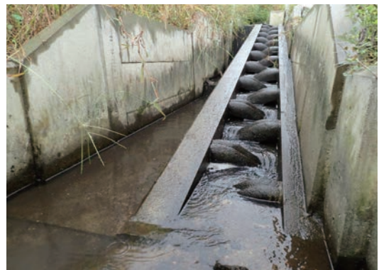
農業農村整備事業で整備された魚道
