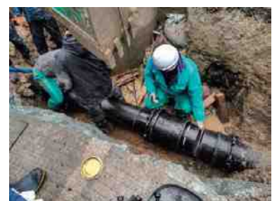
水道管復旧工事
