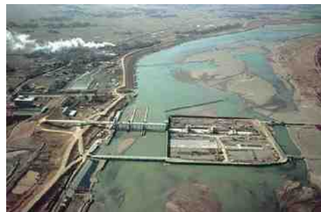
首都圏の急増する水需要に応えるために建設
