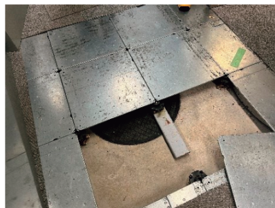
建物地下に設置された雨水貯留槽
