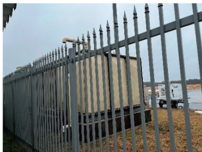
空港滑走路の貯水槽
