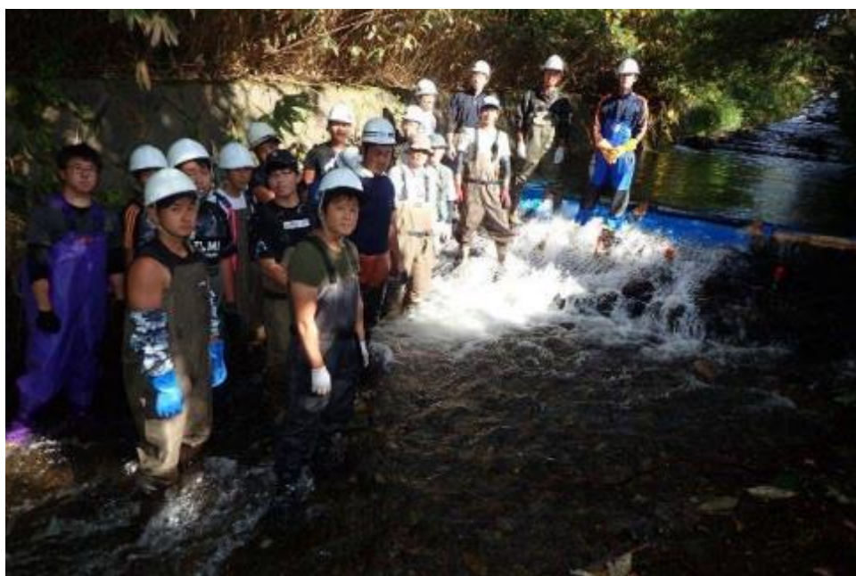
魚道の設置作業
