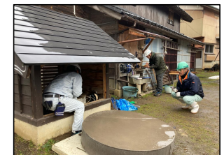
関係団体の既存井戸調査
