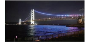
図 ブルーライトアップ(明石海峡大橋)
