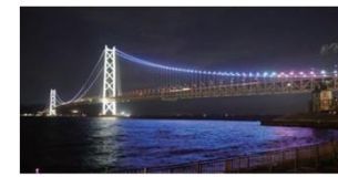
ブルーライトアップ (明石海峡大橋)
