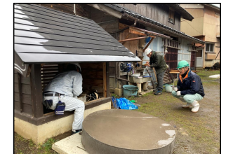
関係団体の既存井戸調査
