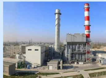
（画像）三菱重工が同国に納入した天然ガス焚複合火力発電所ナヴォイ2（F形ガスタービン）、2019年に商業運転を開始
